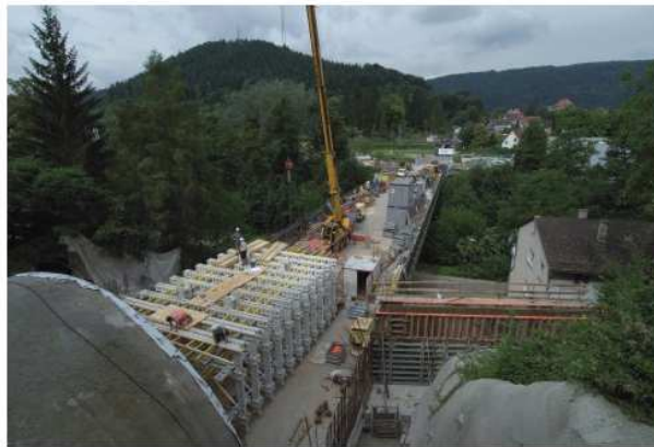
Montaż samonośnego szalunku systemu NOEtec w warunkach ograniczonego miejsca.
