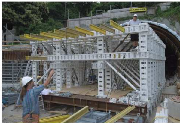
Montaż konstrukcji nośnej z dźwigarów systemu NOEtec.
